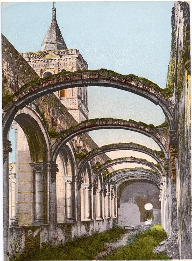
Sevilla. Galeria del Convento de San Jeronimo.
