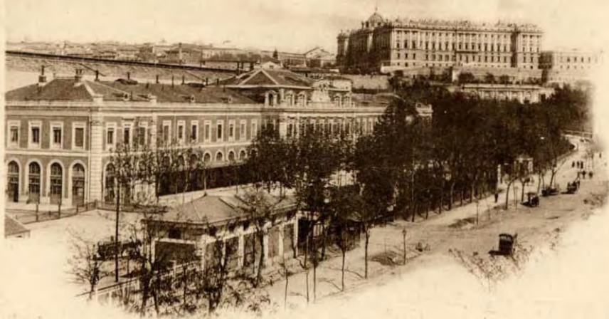
MADRID ESTACIÓN DEL NORTE
