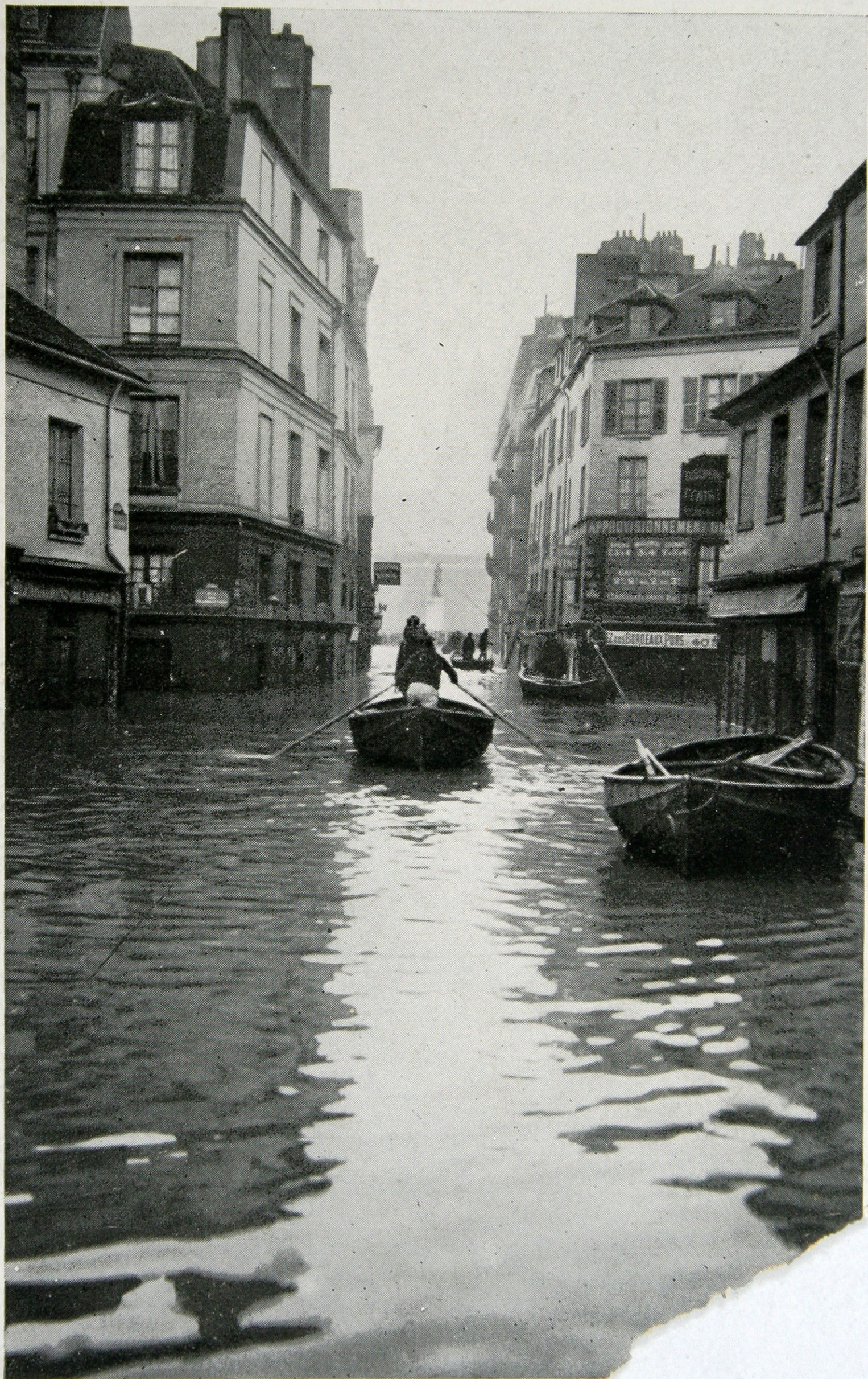
INONDATIONS DE PARIS Rue d'
