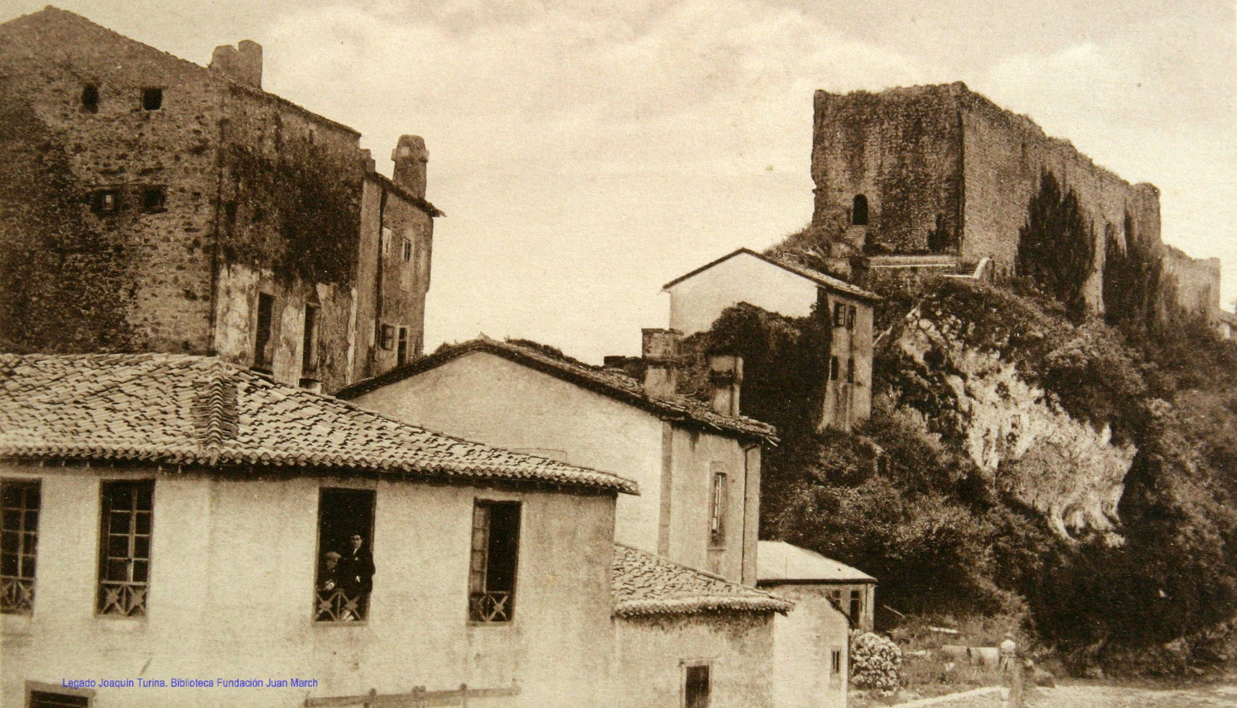
San Vicente de la Barquera - Ruinas de «El Castillo»
