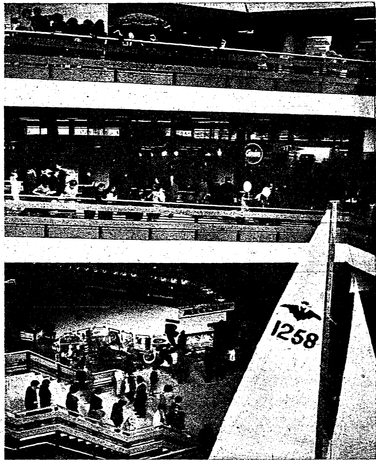
Aspecto parcial de las rampas del Palacio Ferial y de escaleras que las complementan. Asoma al pie un velero del salón náutico, instalado en la parte inferior del edificio, en el centro del patio, coronado por la bóveda de sombrilla. (Foto Postius.)
