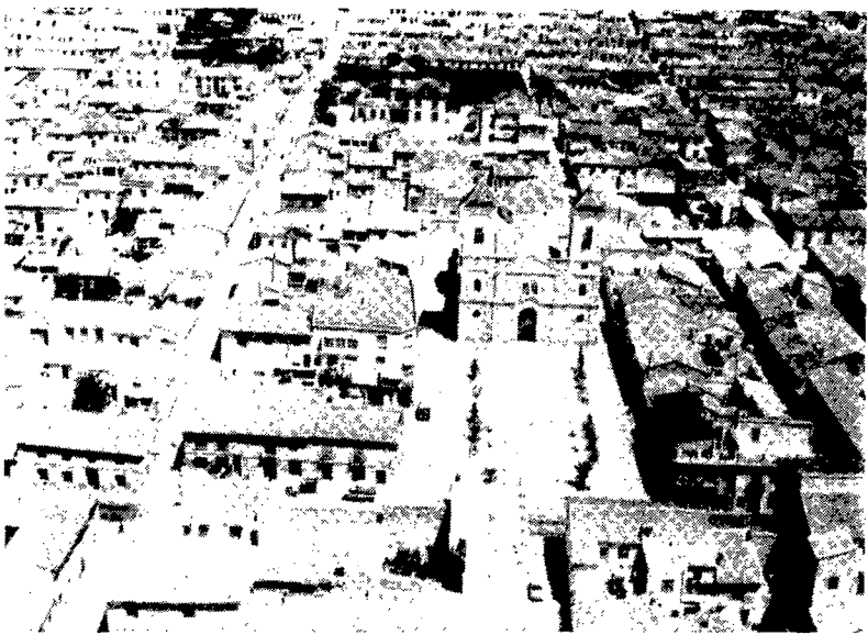
Santomera, vista general. Seis años dura ya la tramitación del expediente de segregación del Ayuntamiento murciano.
