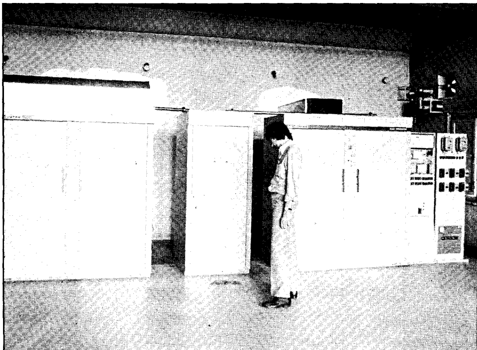
En los huecos al costado del armario depositaron los explosivos.
