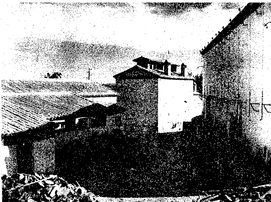
Los locales para el curado de los tabacos "Bright" han de estar dotados de ventilación forzada y de sistemas de calefacción, aparte de otras dependencias en las que se realiza la complicada manipulación que requieren y que ejecuta personal especializado.
