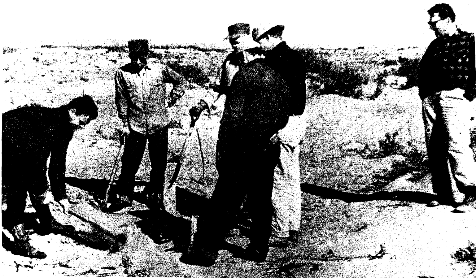
El primer golpe de pico para preparar el antepozo donde se instalará la torre. Un equipo de obreros realiza las iniciales operaciones. En esa misma dirección, la perforadora puede alcanzar hasta 4.500 metros.
