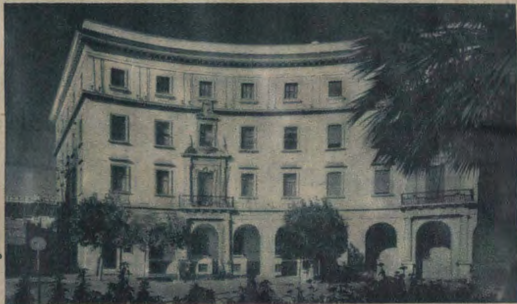
Edificio central de una importante empresa, en Tetuán. (Fotos García Cortés y Zubillaga.)
